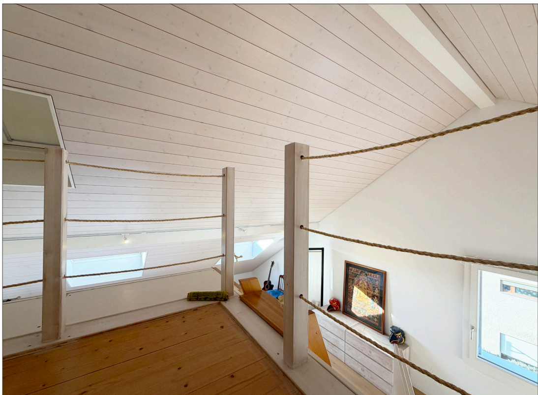
Galerieaufbau über Treppenaufgang im Dachgeschoss
